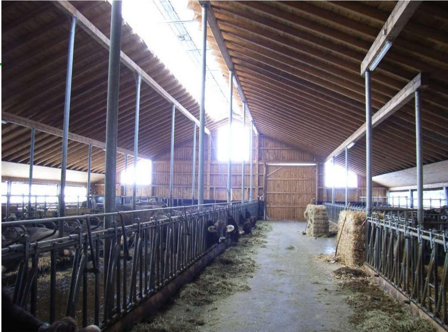
Schlanke Lösung, Außenstützen eingespannt
