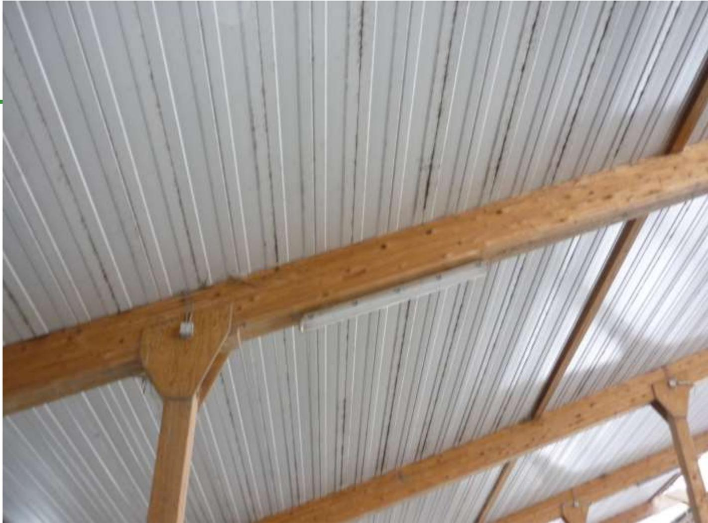
Kältebrücken am Stoß der Blechbahnen → Schimmelbildung
