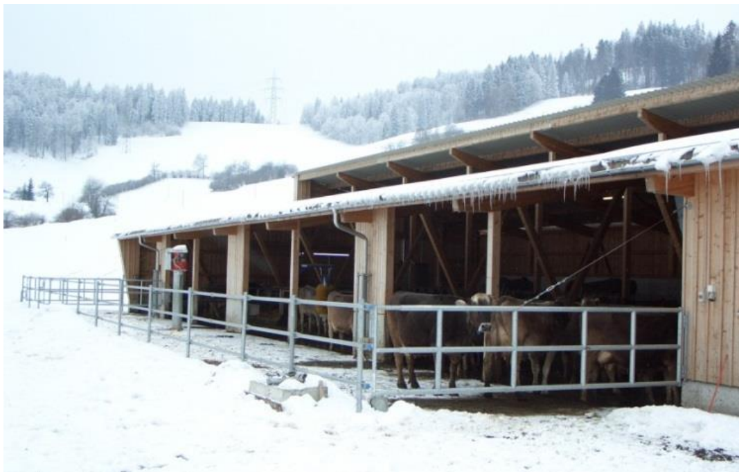
Abb. 6: Blick auf den nicht überdachten Laufhof einer Stallanlage für Milchkühe im Winter
