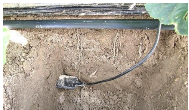
Bild 1: Eingebauter 10 HS unter der Tropfbewässerung
