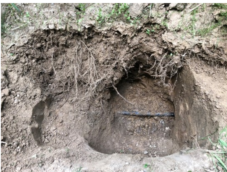
Bild 7, 8: Unterirdische Installation des Tropfschlauches neben den Pflanzreihen in einer Tiefe von 30 cm
