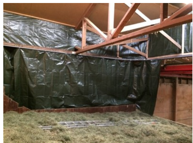
Abb. 17 + 18: Abtrennung einer Heubox durch eine Rollplane: die feuchte Luft wird gezielt über den Umluftkanal zum Luftentfeuchter geführt, somit werden die Energieverluste minimiert (Bildquelle: Christoph Bodenmüller, 2019)
