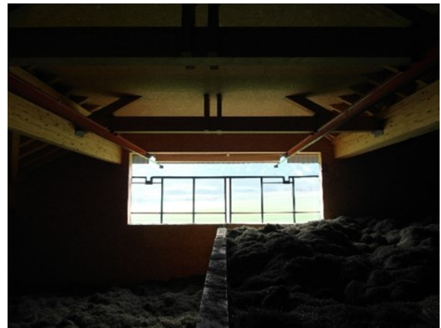
Abb. 15 + 16: Verschließbare Abluftöffnung am Giebel – geschlossen bei Umluftbetrieb (links), offen bei Außenluftbetrieb (rechts; Bildquelle: Christoph Waltner, 2019)
