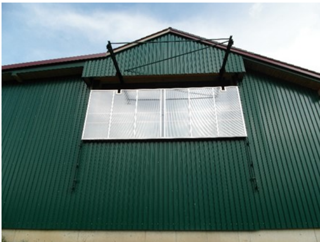
Abb. 15 + 16: Verschließbare Abluftöffnung am Giebel – geschlossen bei Umluftbetrieb (links), offen bei Außenluftbetrieb (rechts; Bildquelle: Christoph Waltner, 2019)
