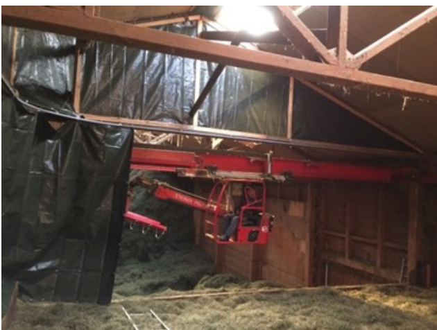
Abb. 17 + 18: Abtrennung einer Heubox durch eine Rollplane: die feuchte Luft wird gezielt über den Umluftkanal zum Luftentfeuchter geführt, somit werden die Energieverluste minimiert (Bildquelle: Christoph Bodenmüller, 2019)
