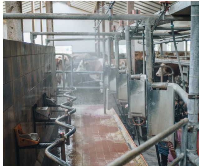
Abb. 19: Melkstand mit Verdunstungskühlung (Betrieb Neichl )
