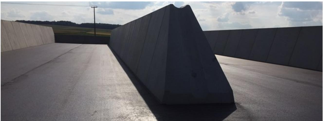
**Bild 10:** Asphalt - Betonfertigteil (schräge Wand)
