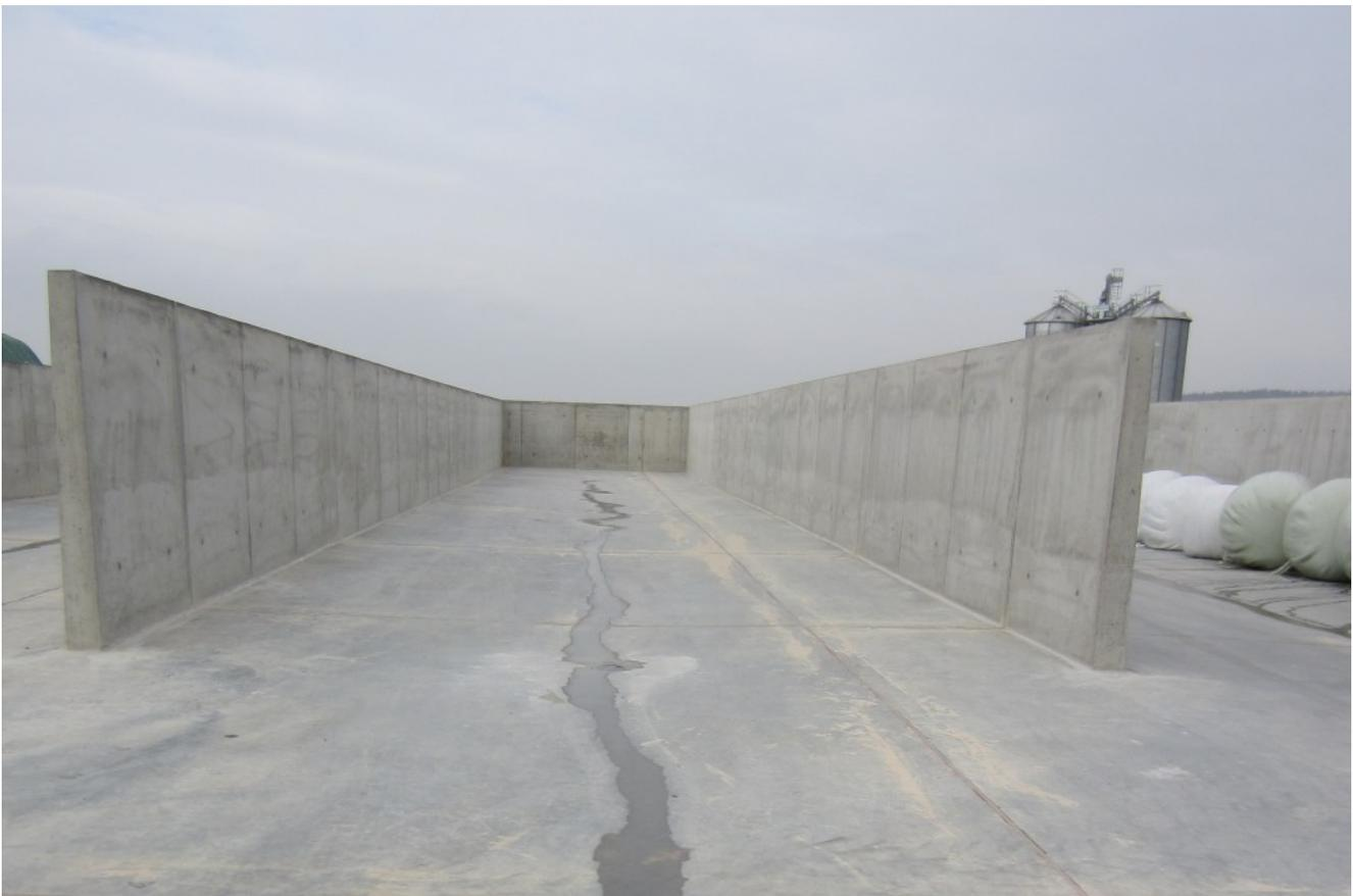
**Bild 2:** Anordnung der Bodenfugen möglichst außerhalb der Wasserführung (Quelle: K. Hoffmann)
