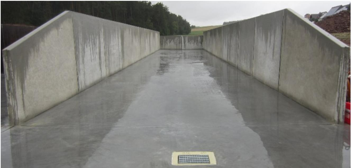
**Bild 8:** Ortbeton - Betonfertigteil (gerade Wand) (Quelle: Klaus Hoffmann)
